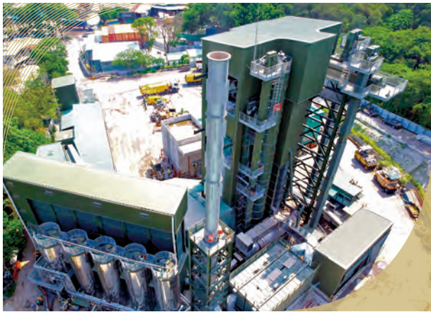
嘉華瀝青有限公司位於香港上水的生產設施
