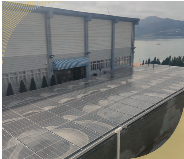
於嘉華建材的大埔客戶服務中心停車場安裝太陽能板。
