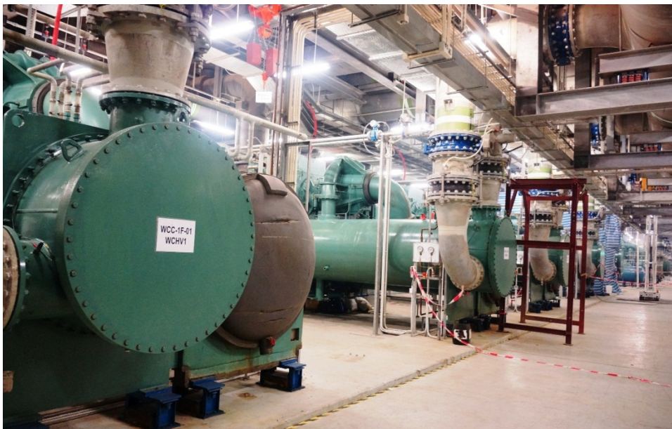
P002：「澳門銀河」其中一项重要的节能措施就是优化制冷机组，藉此减低空调能源消耗。
